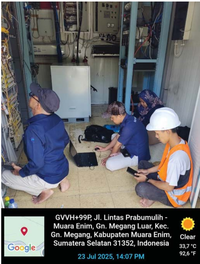
Gambar 3.8 Kegiatan Pemeriksaan stasiun radio Microwave Link di Kab. Muara Enim
